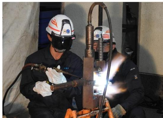
鉄筋圧延継手作業では、実際の炎にビックリ！熱を加える位置を一定に保つのが難しかった。
